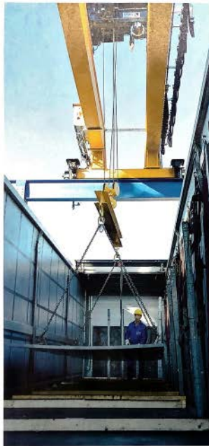
Die neuen Krane helfen bei der Annahme der zahlreichen Stahlbleche.
