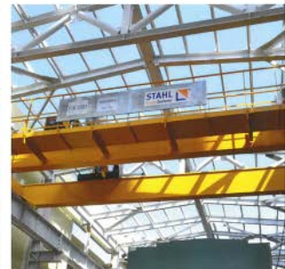
02 为方便操作，在大厅屋顶未完成之前，起重机和葫芦的安装已完成。
