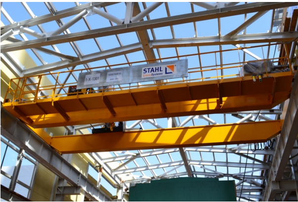
为方便操作，在大厅屋顶未完成之前，起重机和葫芦的安装已完成。
